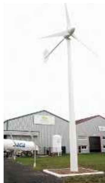
Une éolienne de 12 m pour rendre l'entreprise plus autonome en électricité.
